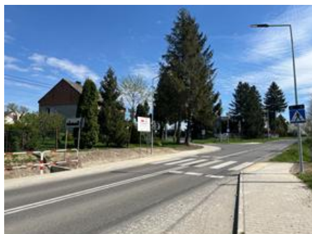
Przebudowana droga powiatowa 1274K w miejscowości Stogniowice
