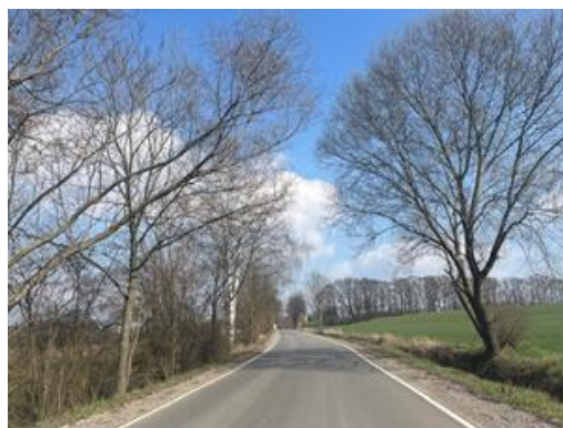
Przebudowana droga powiatowa 1279K w miejscowości Modrzany
