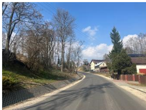
Przebudowana droga powiatowa 1282K w miejscowości Siedliska
