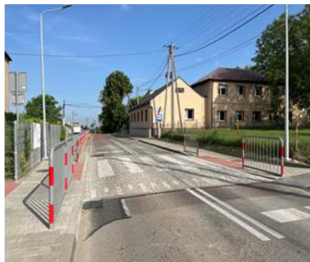
Przebudowana droga powiatowa 1266K w miejscowości Koniusza
