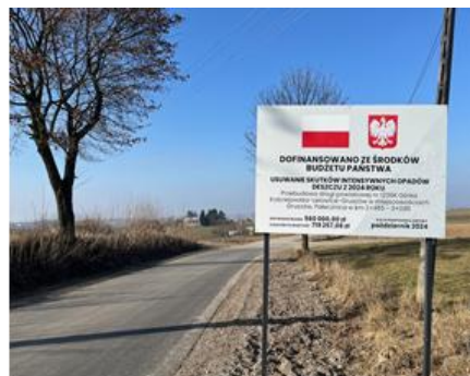
Przebudowana droga powiatowa 1236K w miejscowości Gruszów
