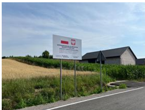
Przebudowana droga powiatowa 1282K w miejscowości Malkowice
