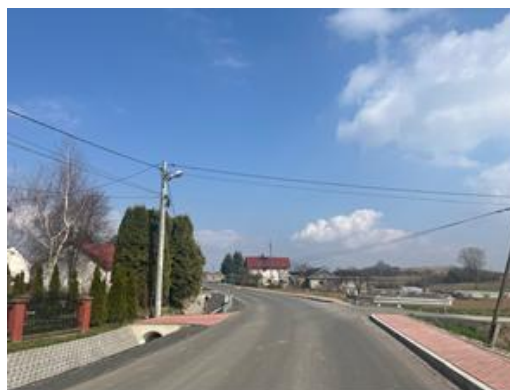
Przebudowana droga powiatowa 1273K w miejscowości Żębocin
