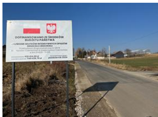
Przebudowana droga powiatowa 1267K w miejscowości Czernichów
