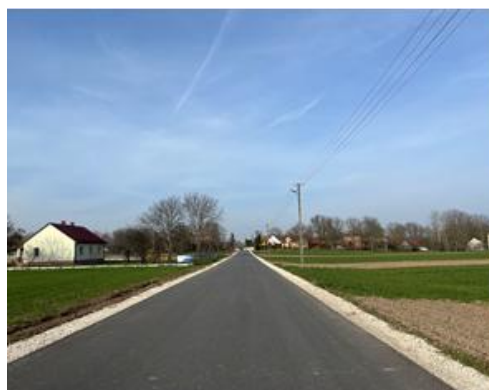
Przebudowana droga powiatowa 1282K w miejscowości Przemyków
