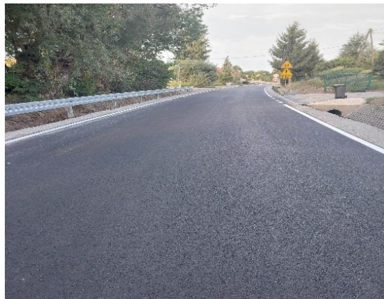
Przebudowana droga powiatowa 1281K w miejscowości Gruszów
