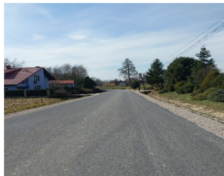
Przebudowana droga powiatowa 1259K w miejscowości Przemęczany
