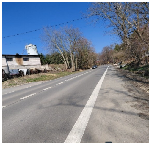
Przebudowana droga powiatowa 1251K w miejscowości Gniazdowice
