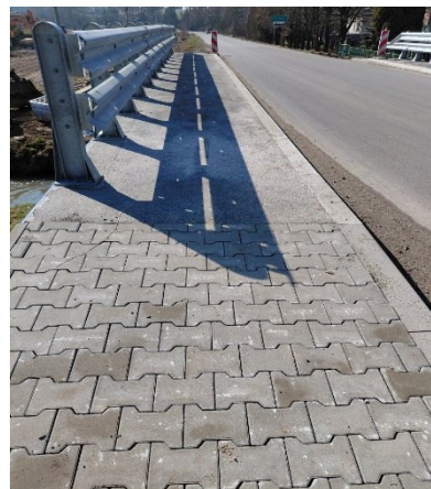
Zmodernizowany most w ciągu drogi 1251K w miejscowości Gniazdowice
