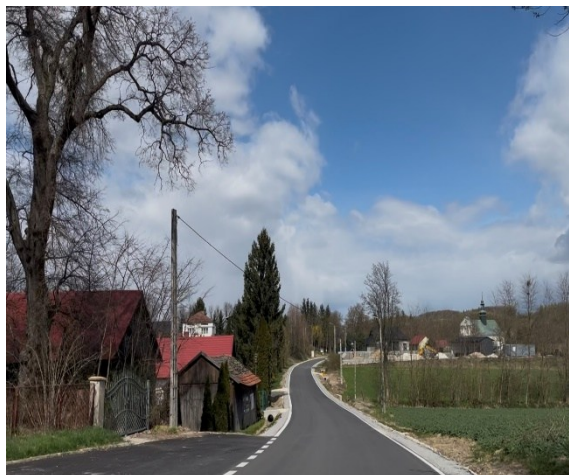
Przebudowana droga powiatowa 1235K w miejscowości Wrocimowice
